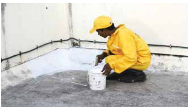
a. Applying the primer
