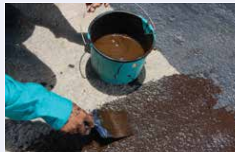
a. Application of the primer
