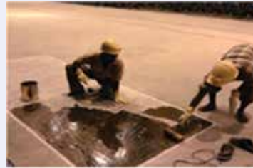
Fig. 4: Application of Dr. Fixit Pidipoxy EP primer
