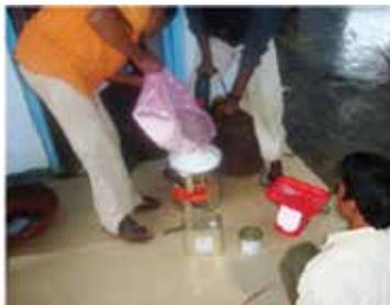
Fig. 17: Mixing of primer Dr. Fixit Pidipoxy EP
