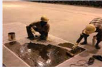
Fig. 4: Application of Dr. Fixit Pidipoxy EP primer
