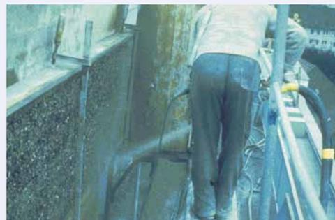
Fig. 3 : Spray concrete
